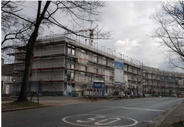
Abbildung 1: Laufende Bauprojekte in Bochum
