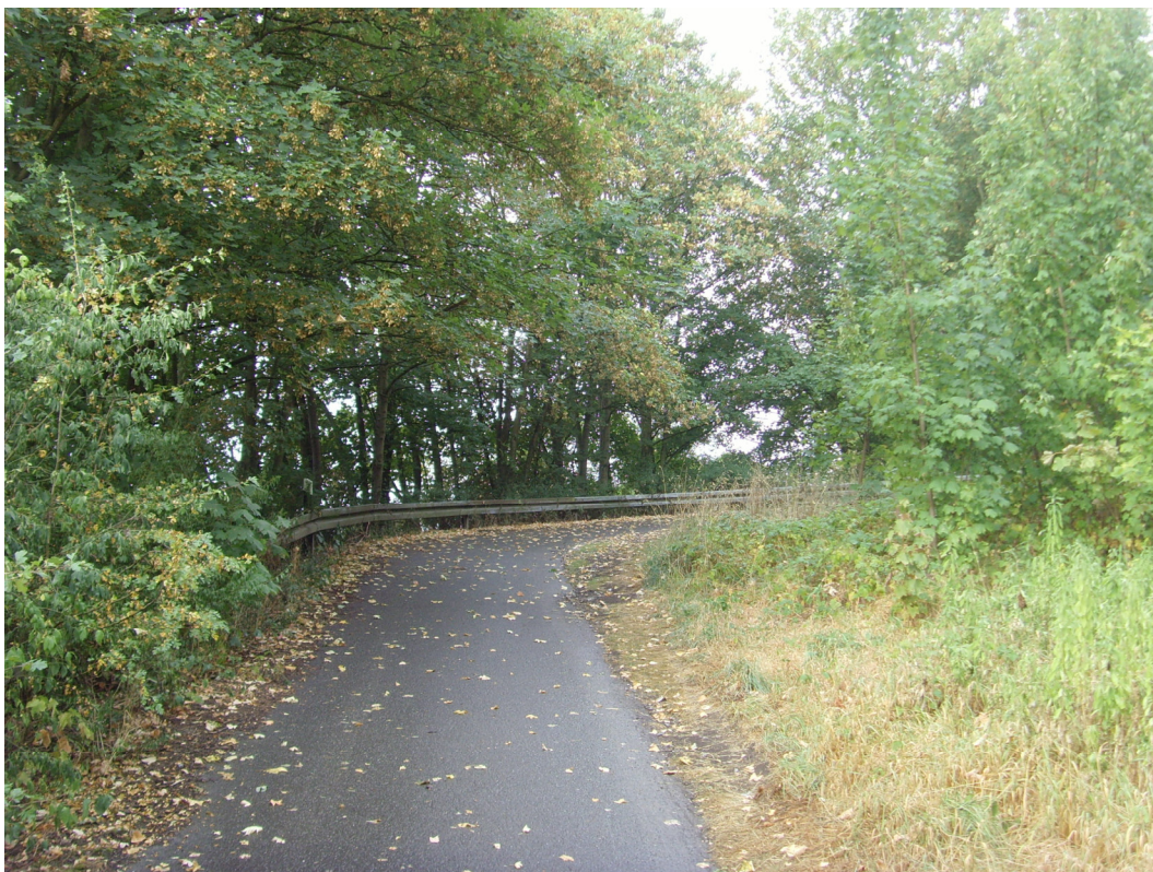
Anbindung an Rampe/Brückenbauwerk Richtung Ümminger See
