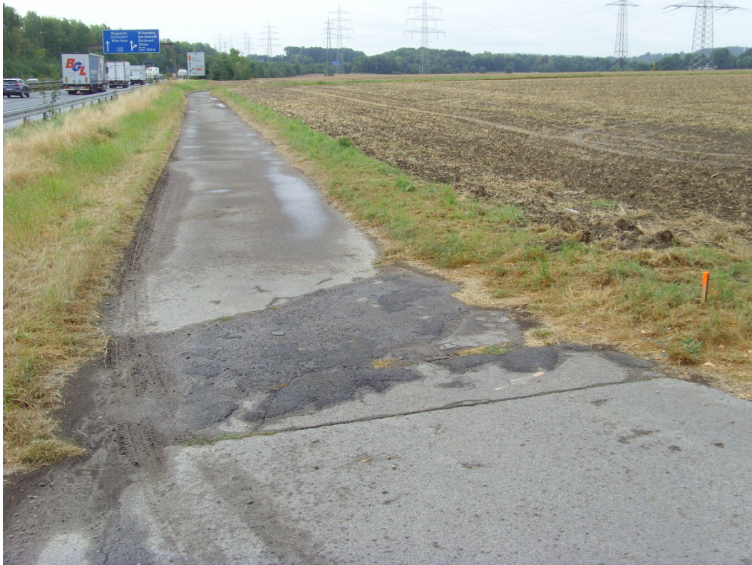
Teilstück Wegetrasse entlang A 43
