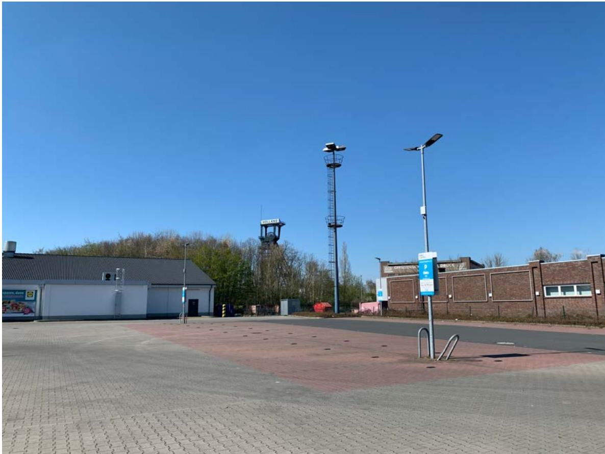
Ansicht von Lyrenstraße Höhe Parkplatz Supermarkt
